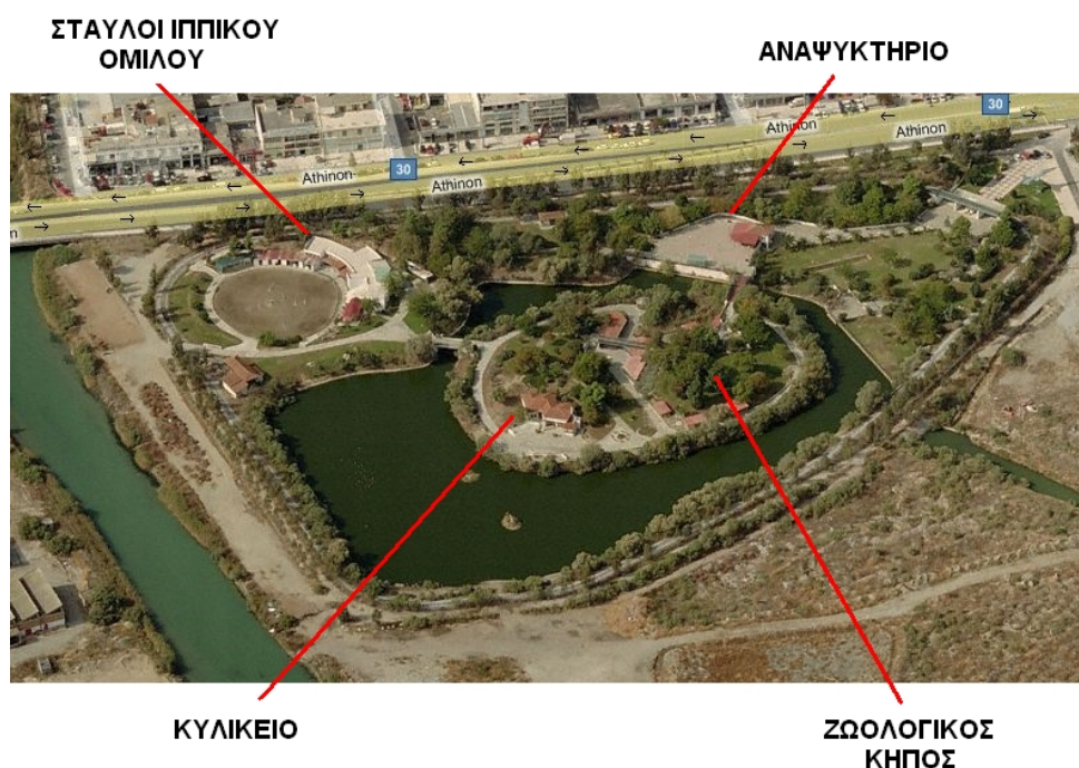
Εικόνα 4.3 Εγκαταστάσεις στο Πάρκο του Πεδίου Άρεως
