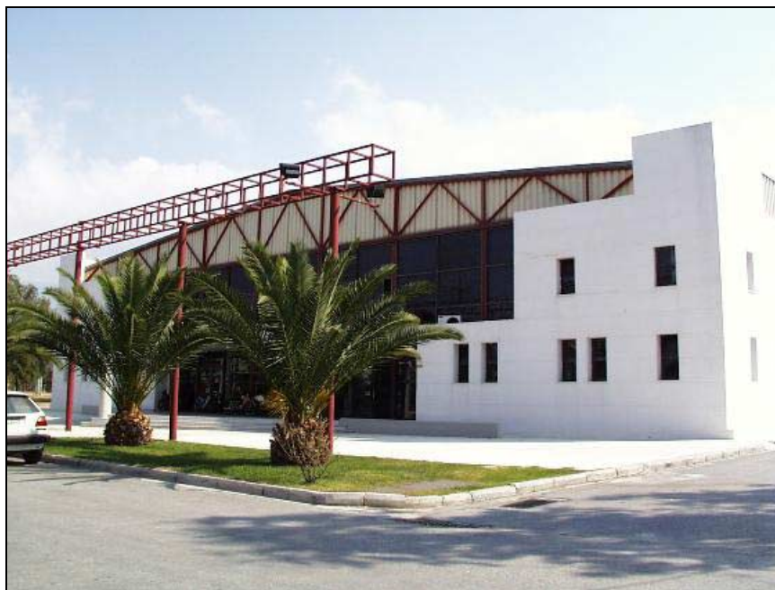
είσοδος εκθεσιακού κέντρου
