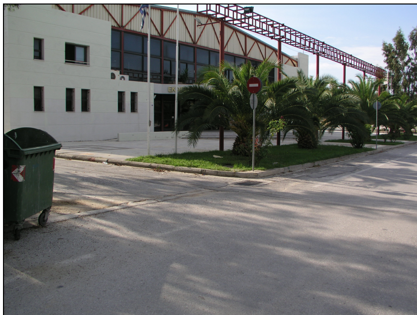
είσοδος εκθεσιακού κέντρου
