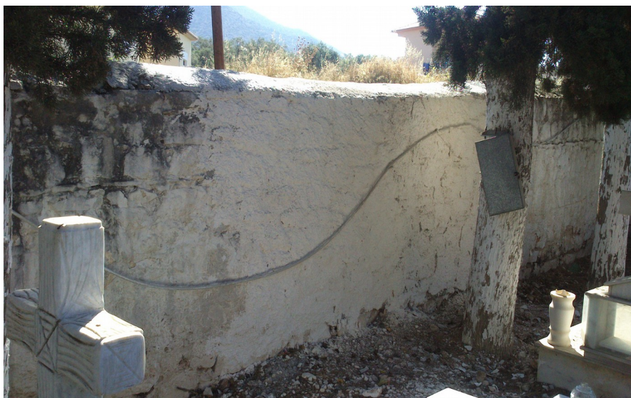
Εικ. επισκευή τοίχου στο κοιμητήριο της Αγριάς.
