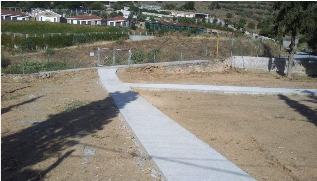
Εικ. Κατασκευή διαδρόμων, στο κοιμητήριο Διμηνίου.
