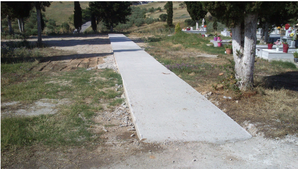
Εικ. Κατασκευή διαδρόμου στο κοιμητήριο του Σέσκλου.
