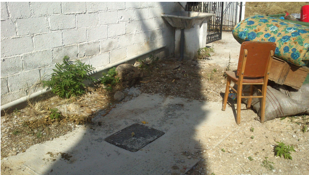
Εικ. Κατασκευή σηπτικού βόθρου στο κοιμητήριο του Σέσκλου.
