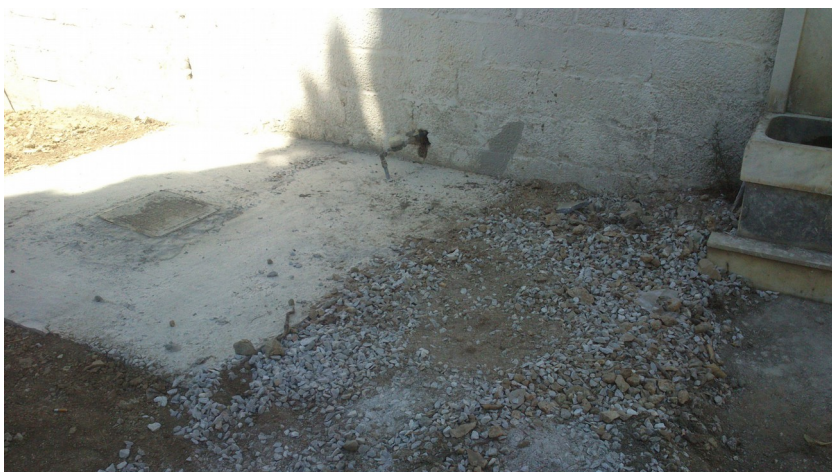
Εικ. Κατασκευή σηπτικού βόθρου στο κοιμητήριο του Αγ. Ονουφρίου.
