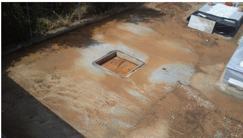
Εικ. Κατασκευή χωνευτηριού στο κοιμητήριο της Άλλης Μεριάς.
