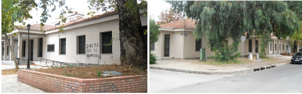
Εικ. 2-3. Υπάρχουσα κατάσταση του κτιρίου (πρώην Υγειονομικό).
