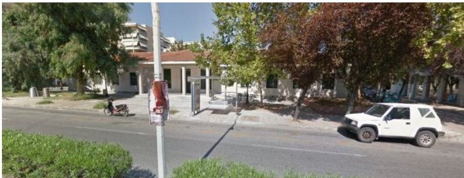
Εικ. 4. Υπάρχουσα κατάσταση του κτιρίου (πρώην Υγειονομικό).
