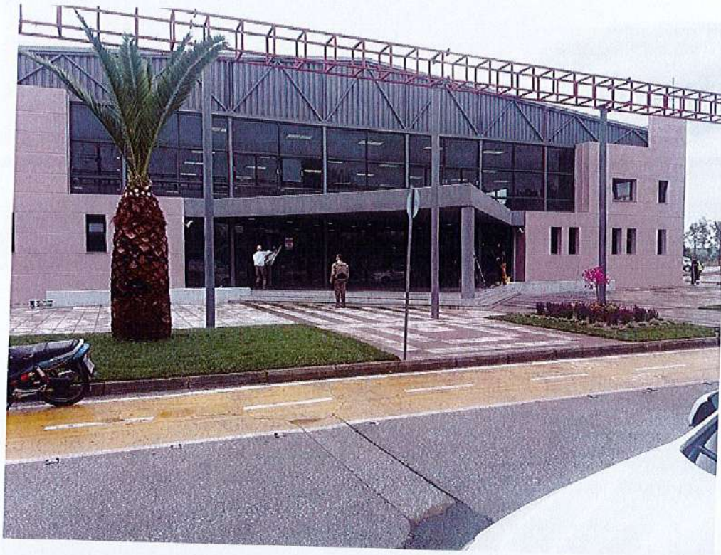
ΟΨΗ ΚΤΙΡΙΟΥ 'ΣΥΝΕΔΡΙΚΟ ΚΕΝΤΡΟ'
