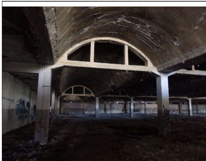
Κτήριο 17. ΚΛΩΣΤΗΡΙΟ Ι (ισόγειο κελυφωτό από οπλισμένο σκυρόδεμα) E=9129τμ
