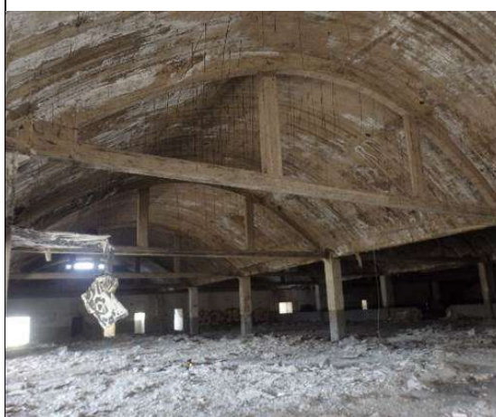
Κτήριο 17. ΚΛΩΣΤΗΡΙΟ Ι (ισόγειο κελυφωτό από οπλισμένο σκυρόδεμα) E=9129τμ
