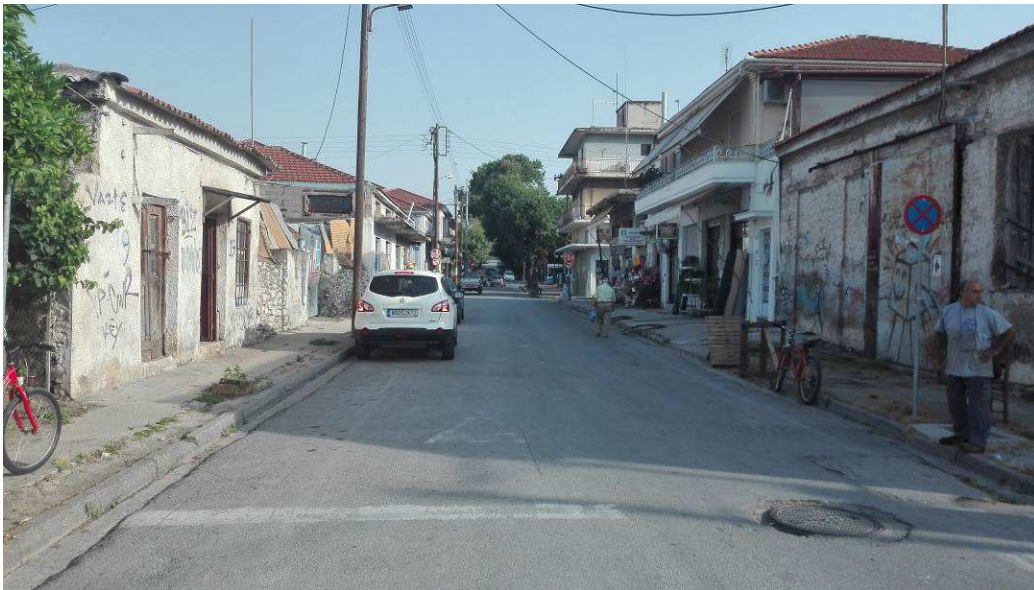
Εικ. 3: Οδός Μητροπολίτη Γρηγορίου (λήψη από την οδό Πυράσσου)
