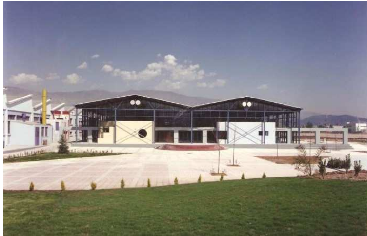
Πολυτεχνικές Σχολές του Πανεπιστημίου Θεσσαλίας, πρώην αποθήκη μηχανουργικού εργοστασιακού συγκροτήματος ((ανακτήθηκε από http://www.adamakis-architects.gr/ )
