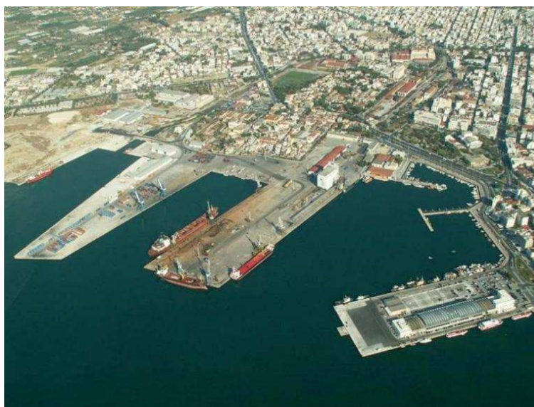
Το Λιμάνι του Βόλου στα νότια της περιοχής ( ανακτήθηκε από https://www.port-volos.gr/ ).
